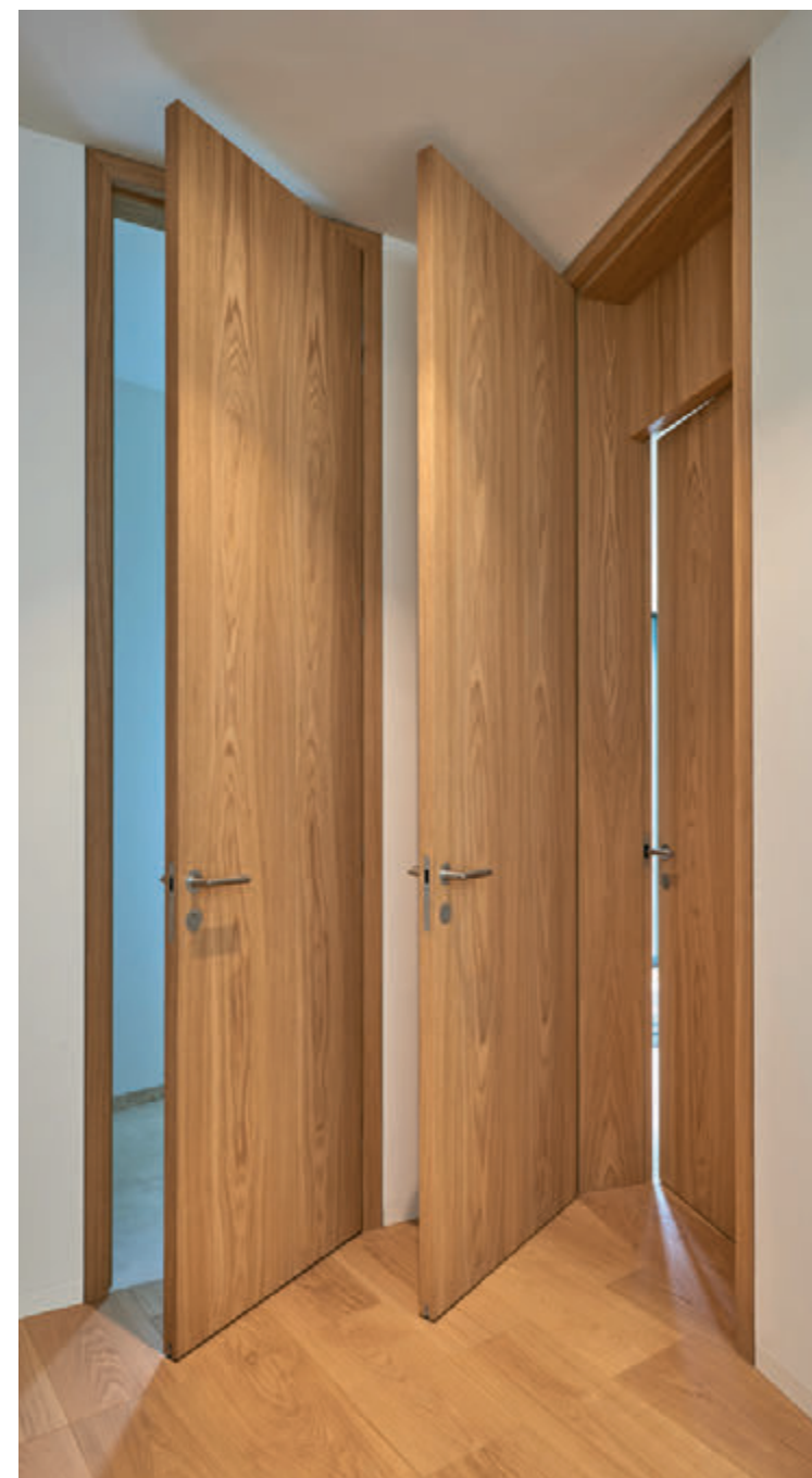
Provedení dveří s kontrazárubní, výška 3 m
